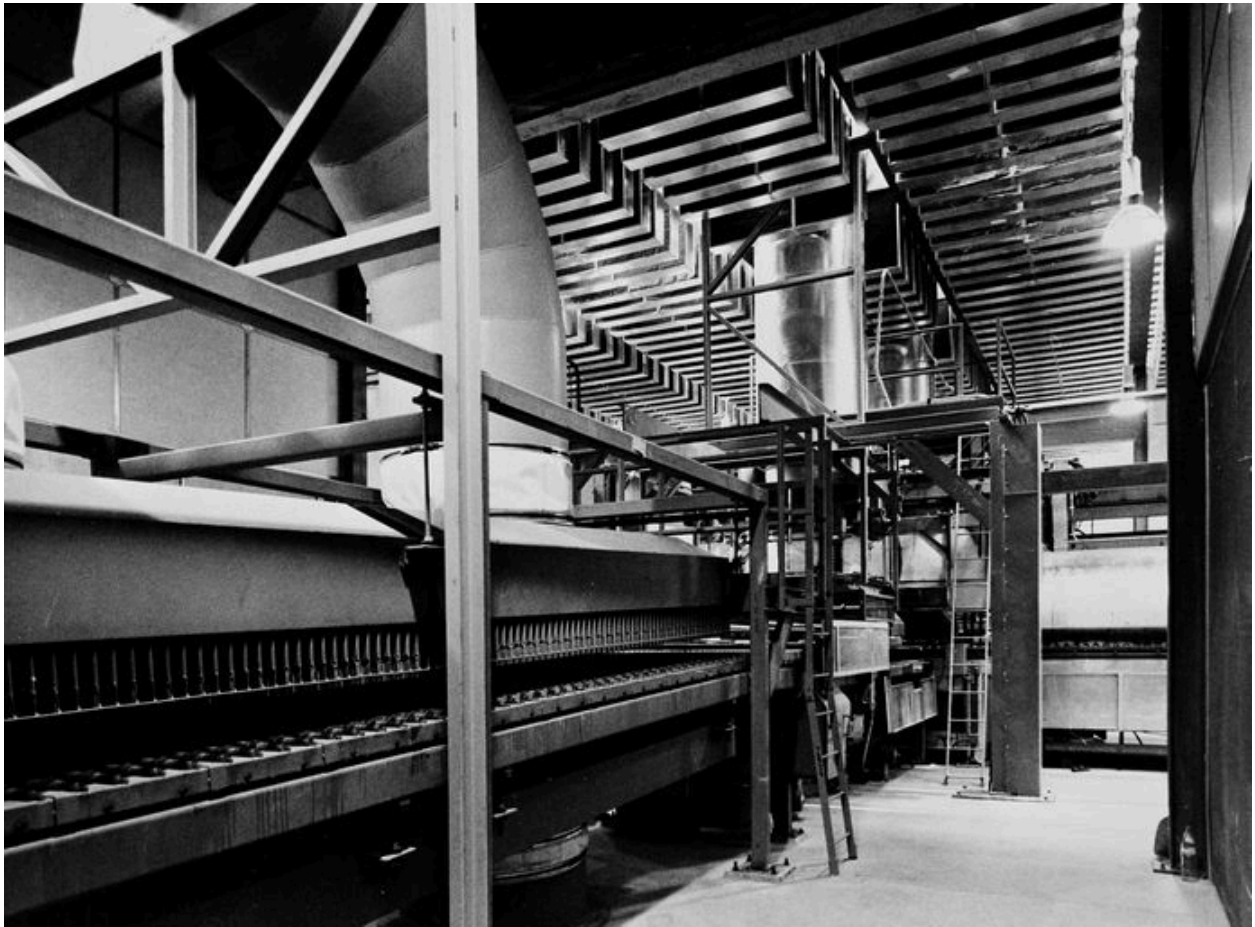
Atelier de fabrication : vue intérieure, vers 1925 (AP).
