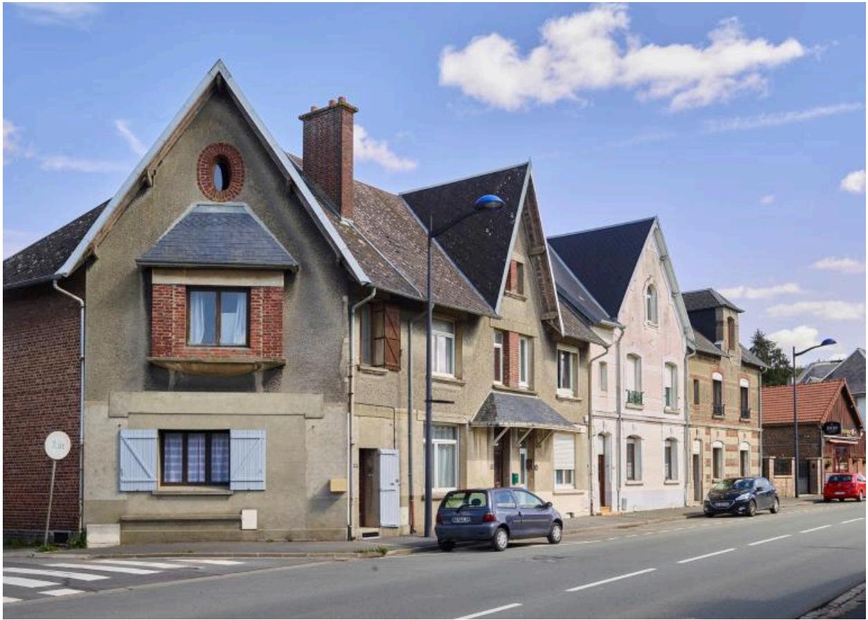
Maison à deux unités d'habitation, n°48-50 rue du faubourg de Péronne.
