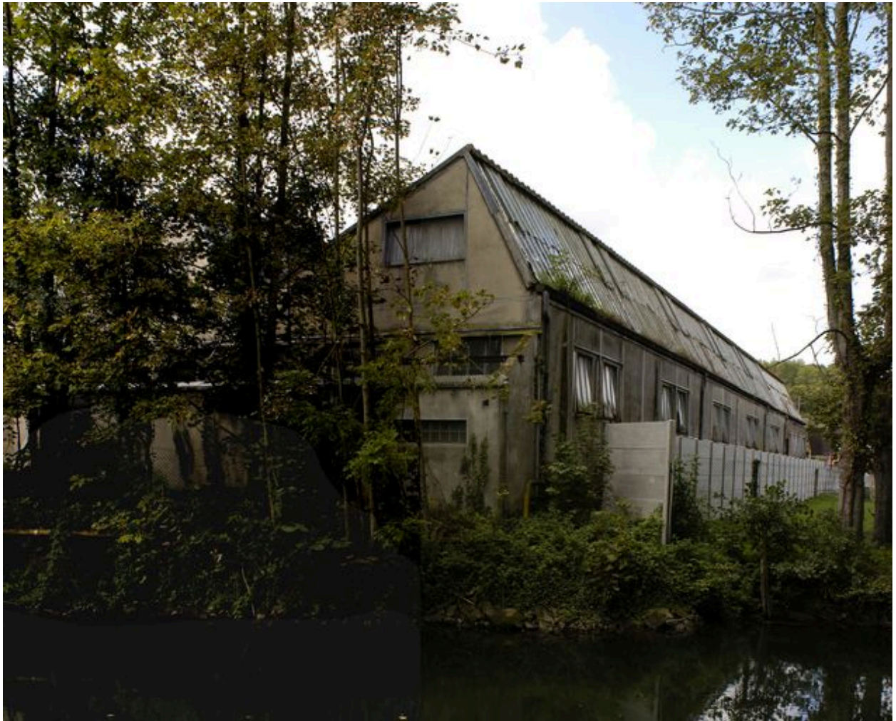
Vue de la dernière travée en shed de l'atelier de fabrication.
