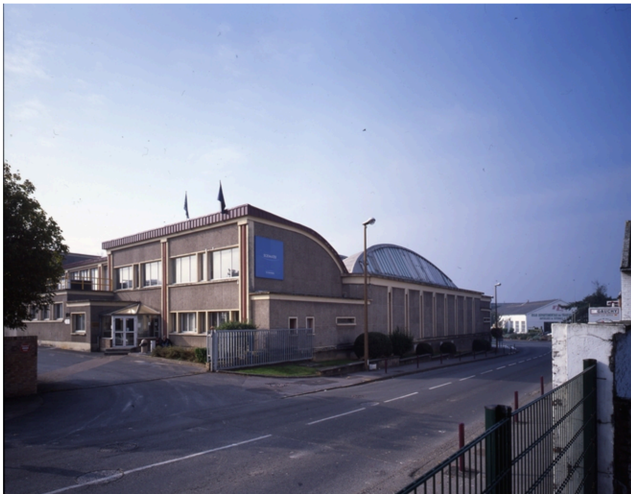
Façade de l'usine, rue Pierre-Semard.
