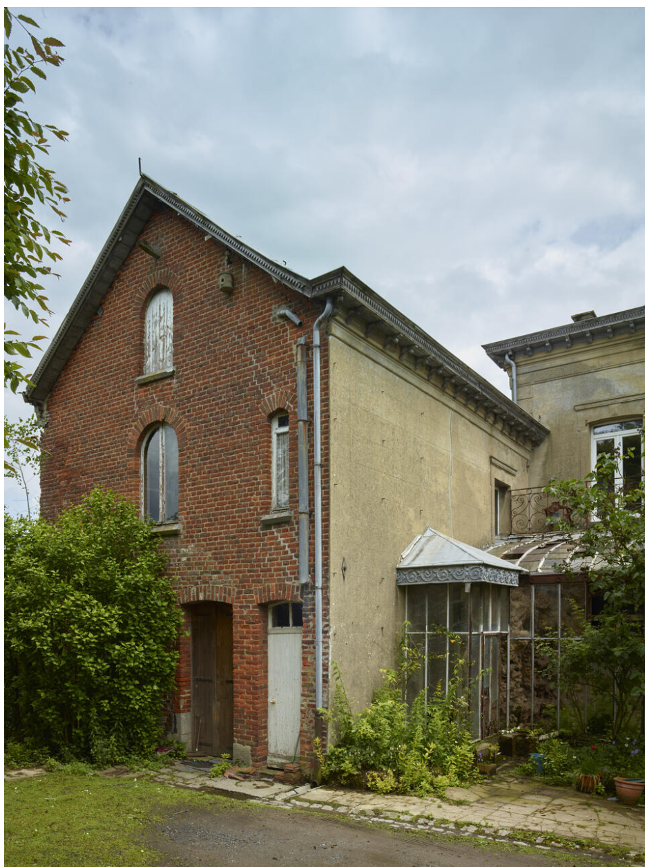
Aile en retour sur jardin de la maison d'habitation de l'industriel.
