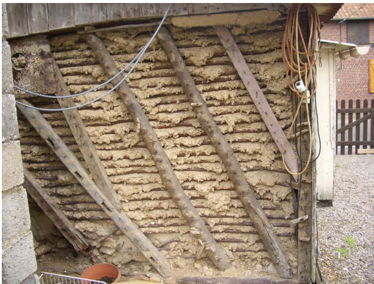
Vue détaillée de la maçonnerie de l'atelier en torchis et pans de bois.
