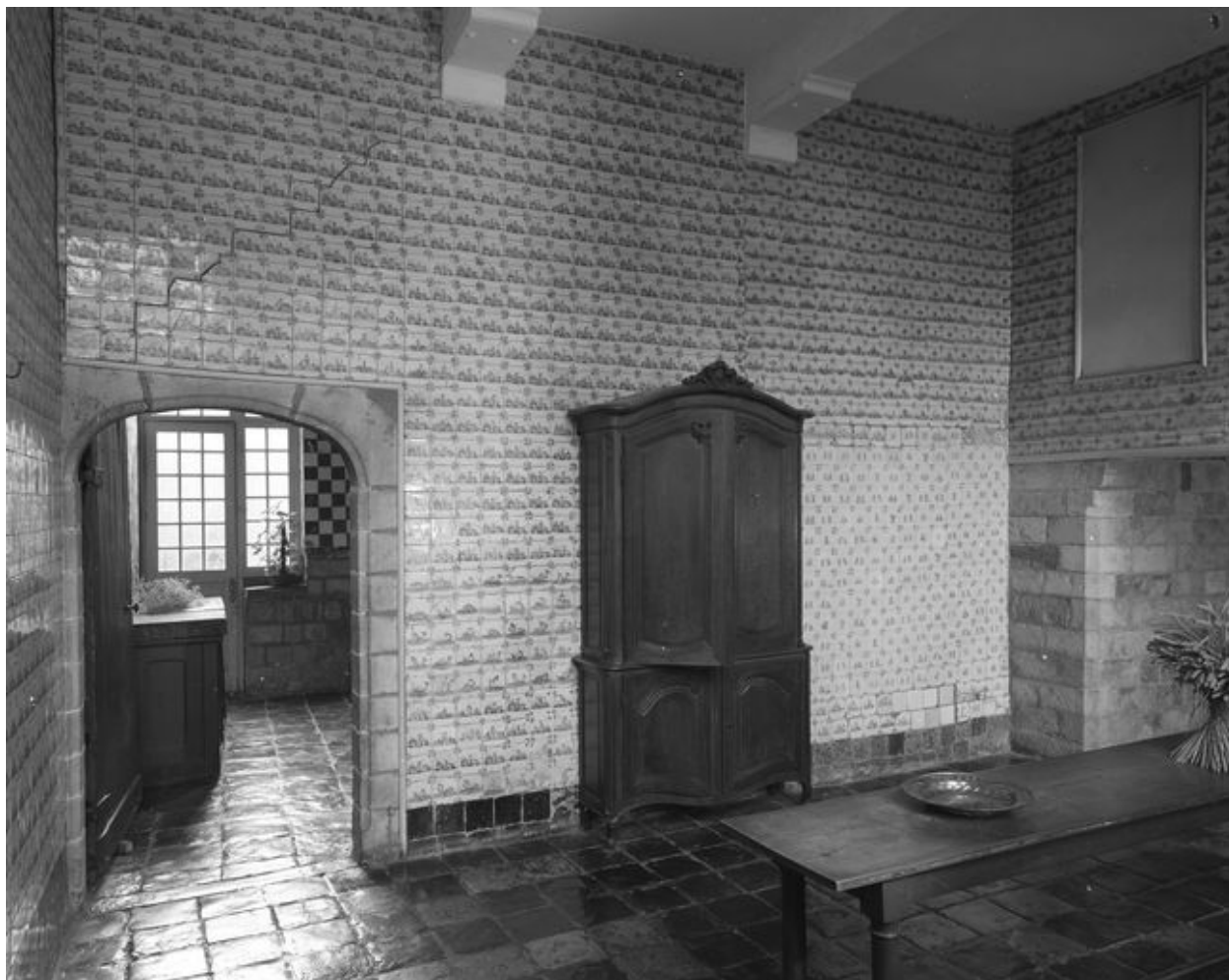
Bâtiment de la communauté religieuse, rez-de-chaussée, ancienne cuisine, élévation intérieure de la paroi située à gauche de la cheminée, vue générale.
