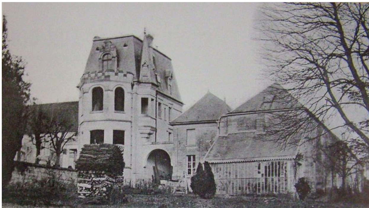
Vue de l'ancien prieuré (AD Aisne : 15 R 1574).
