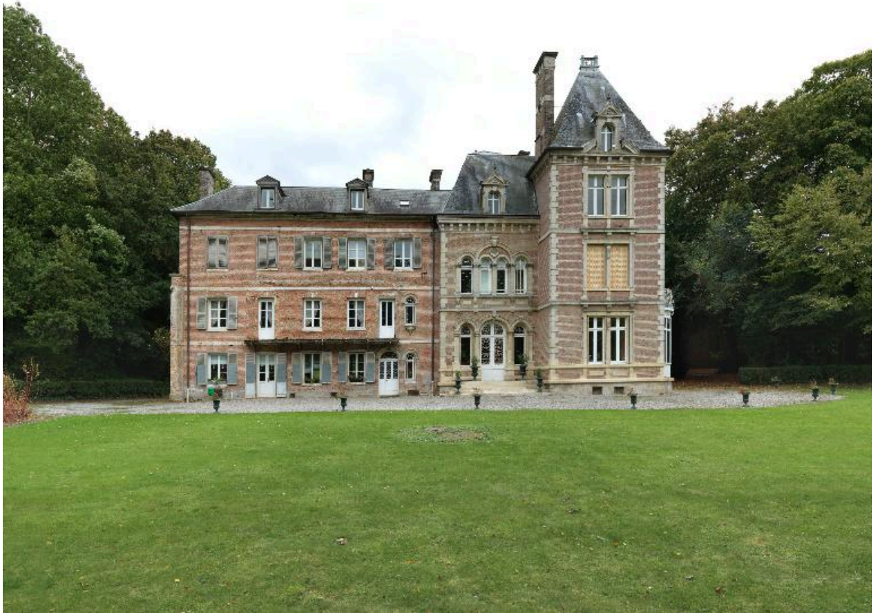
Vue d'ensemble de la façade nord.
