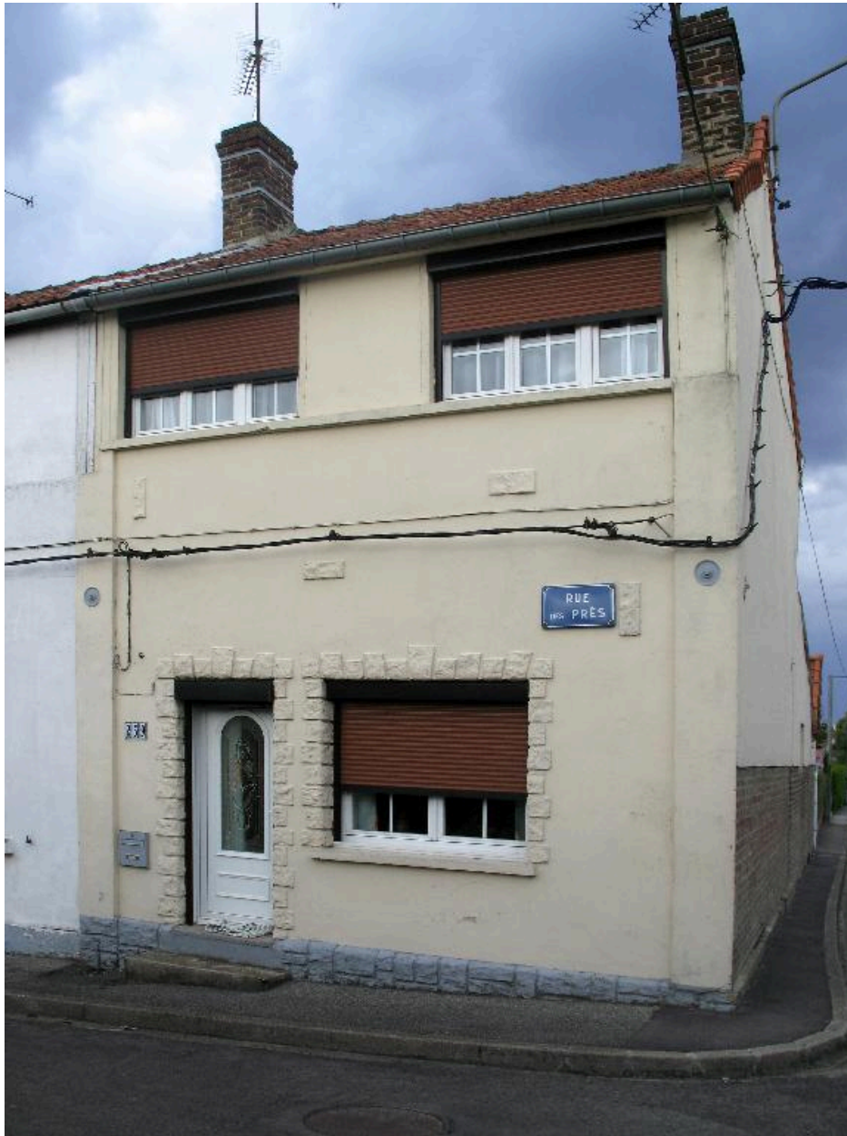
Façade sur rue du logement ouvrier 259 rue des Prés.
