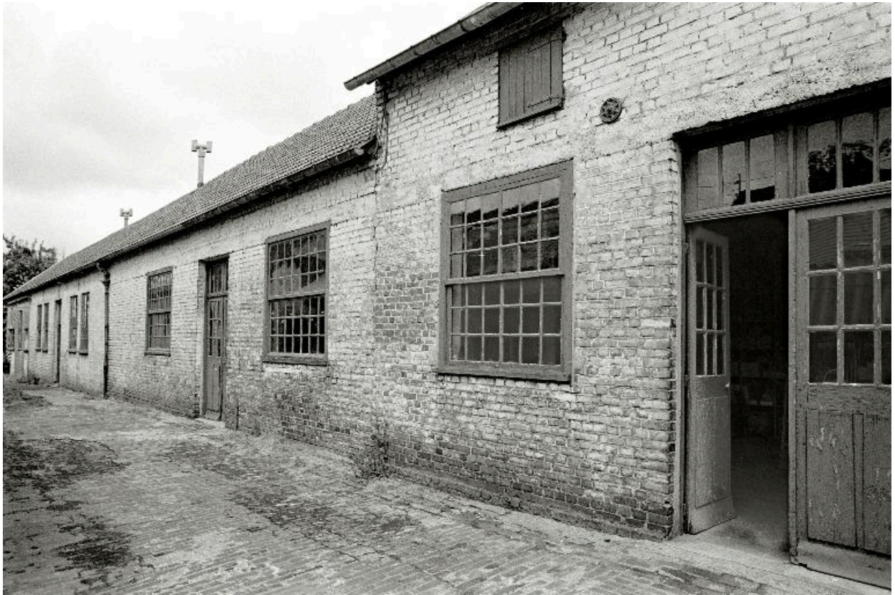
Ateliers de fabrication, élévation antérieure, en 1990.
