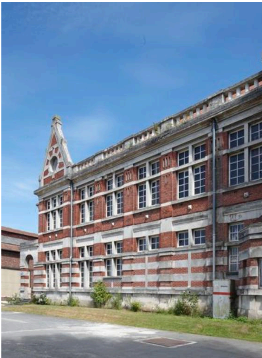
Vue partielle des bureaux, élévation antérieure.
