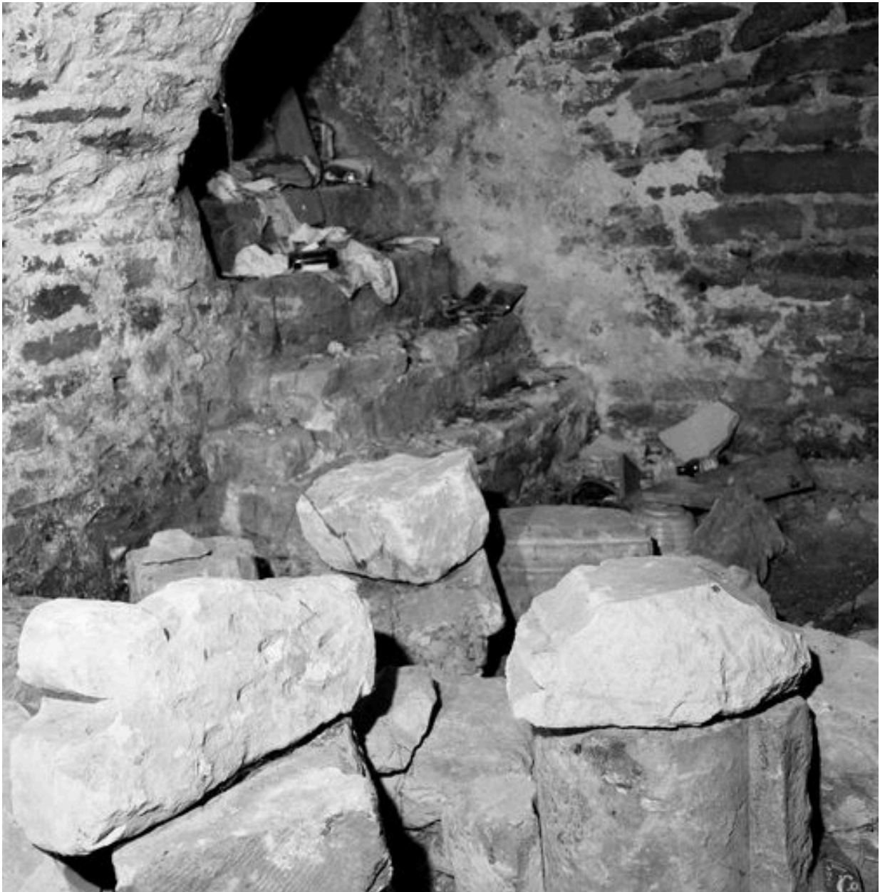
Corps de logis médiéval, intérieur, cave, escalier d'accès d'origine (fermé), donnant sur la façade arrière.
