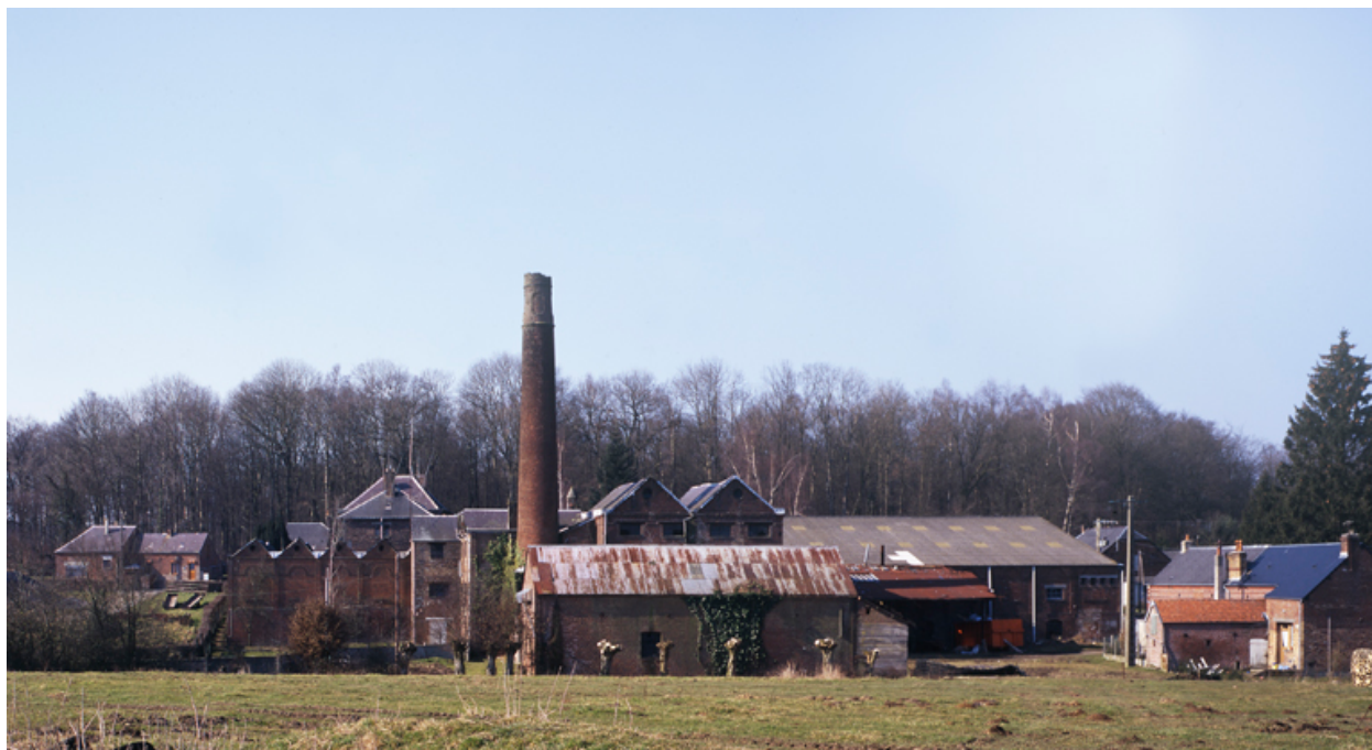
Vue générale de l'usine, depuis le sud-est.
