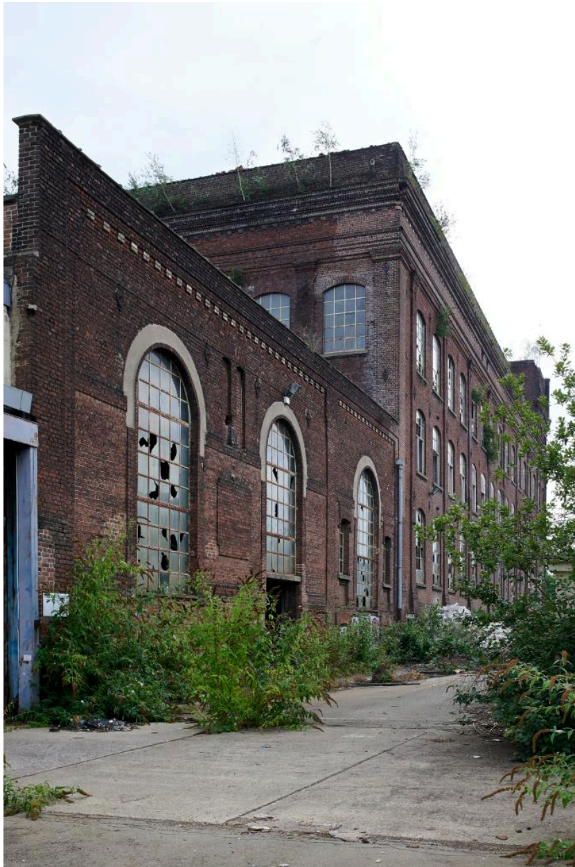
Élévation sud-ouest de la salle des machines, au premier plan, et de la filature.
