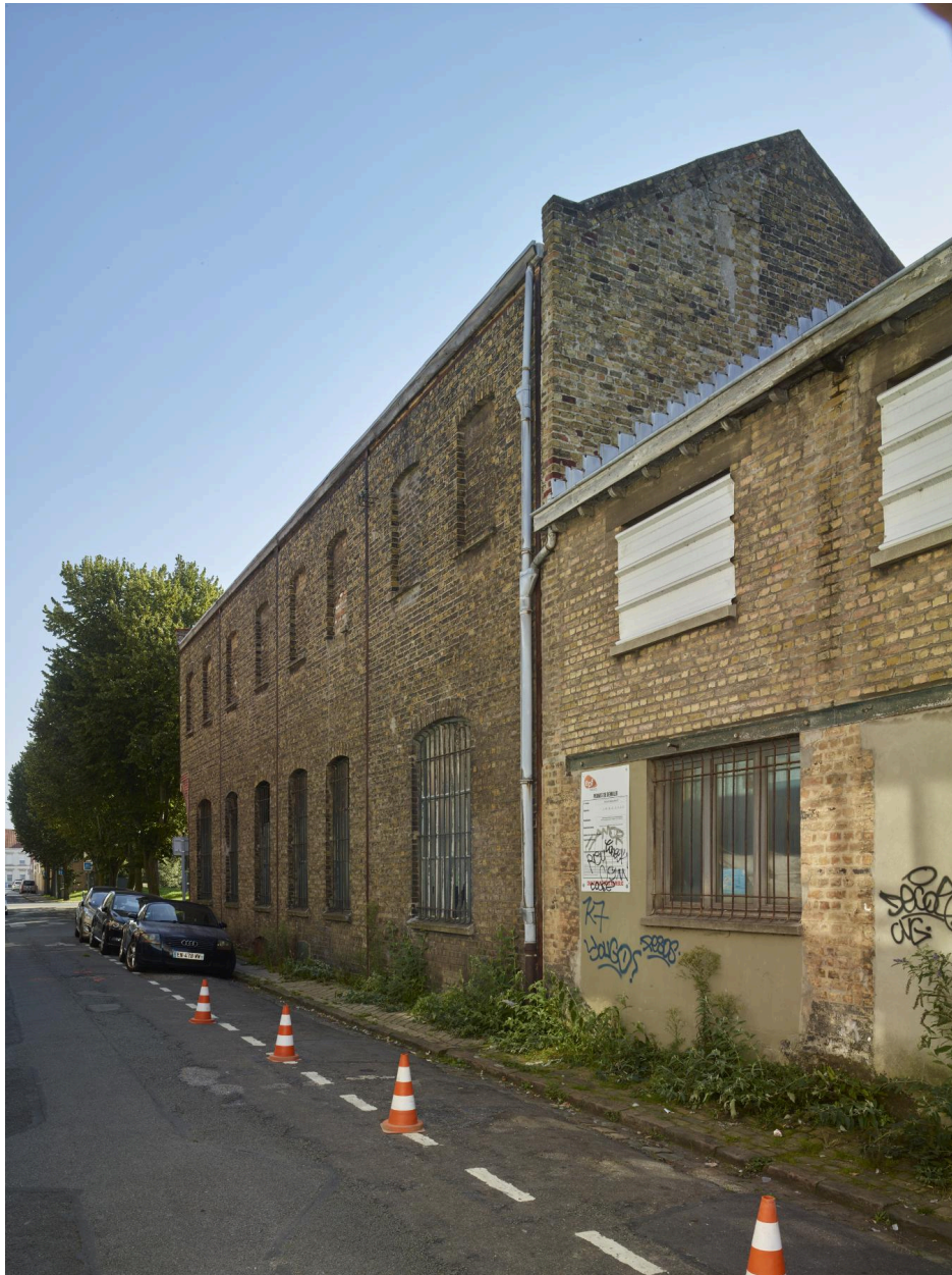
Élévation rue François-Tixier, vers l'est.
