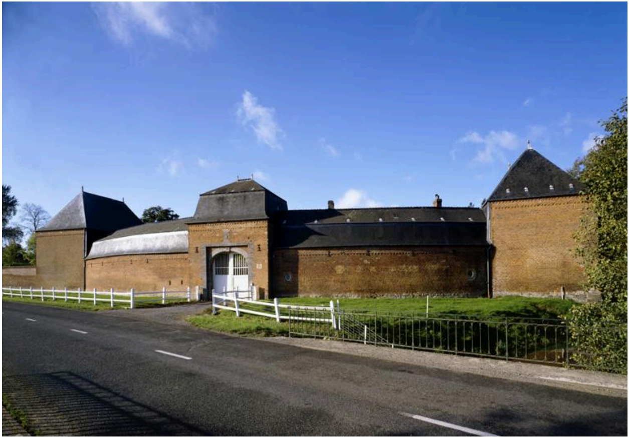
La ferme du château, vue depuis la route.
