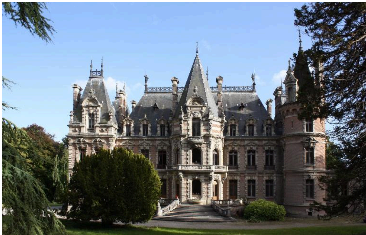
Vue d'ensemble de la façade nord du château.
