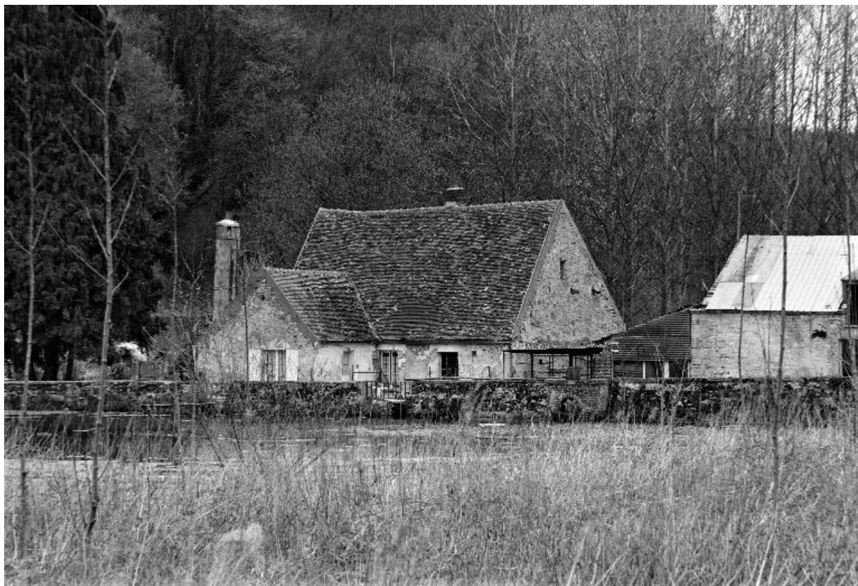
Le moulin, vu depuis l'ouest.
