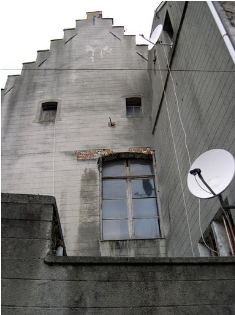
Façade latérale sud-est, vue partielle : pignon à redents, baie de la salle des bateliers.
