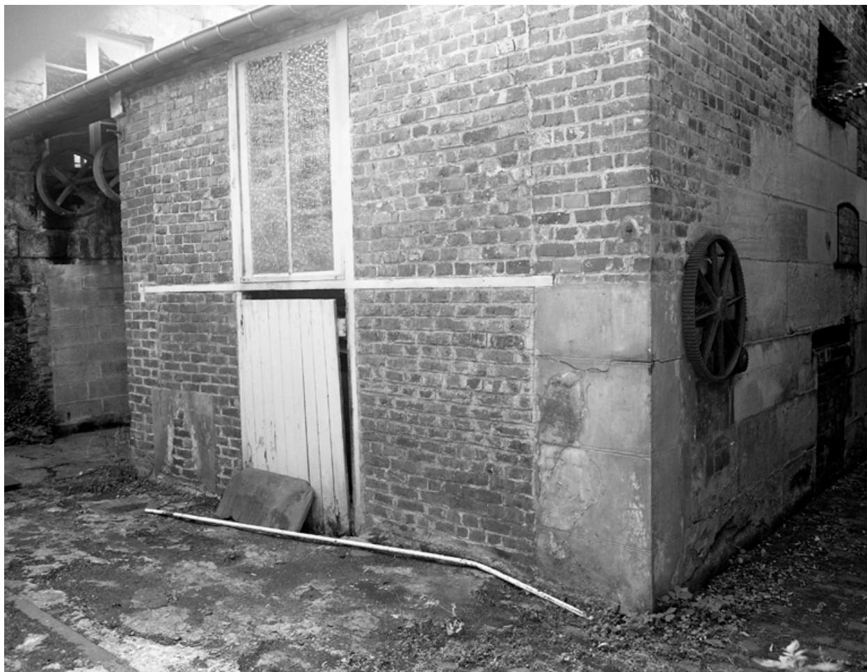
Façade nord de la salle des machines.
