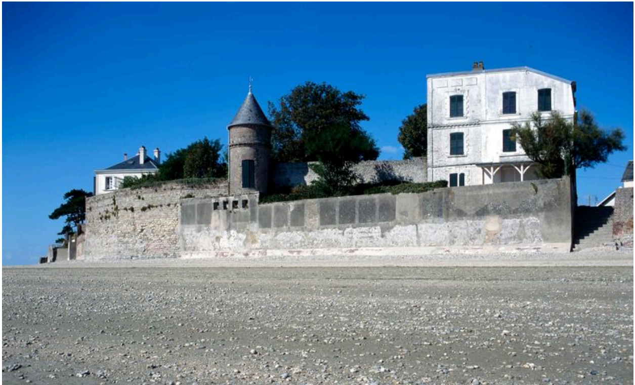
Le mur d'enceinte et escalier d'accès à la rue du Château.
