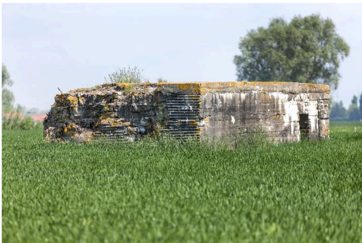
Vue de trois-quarts vers le nord
