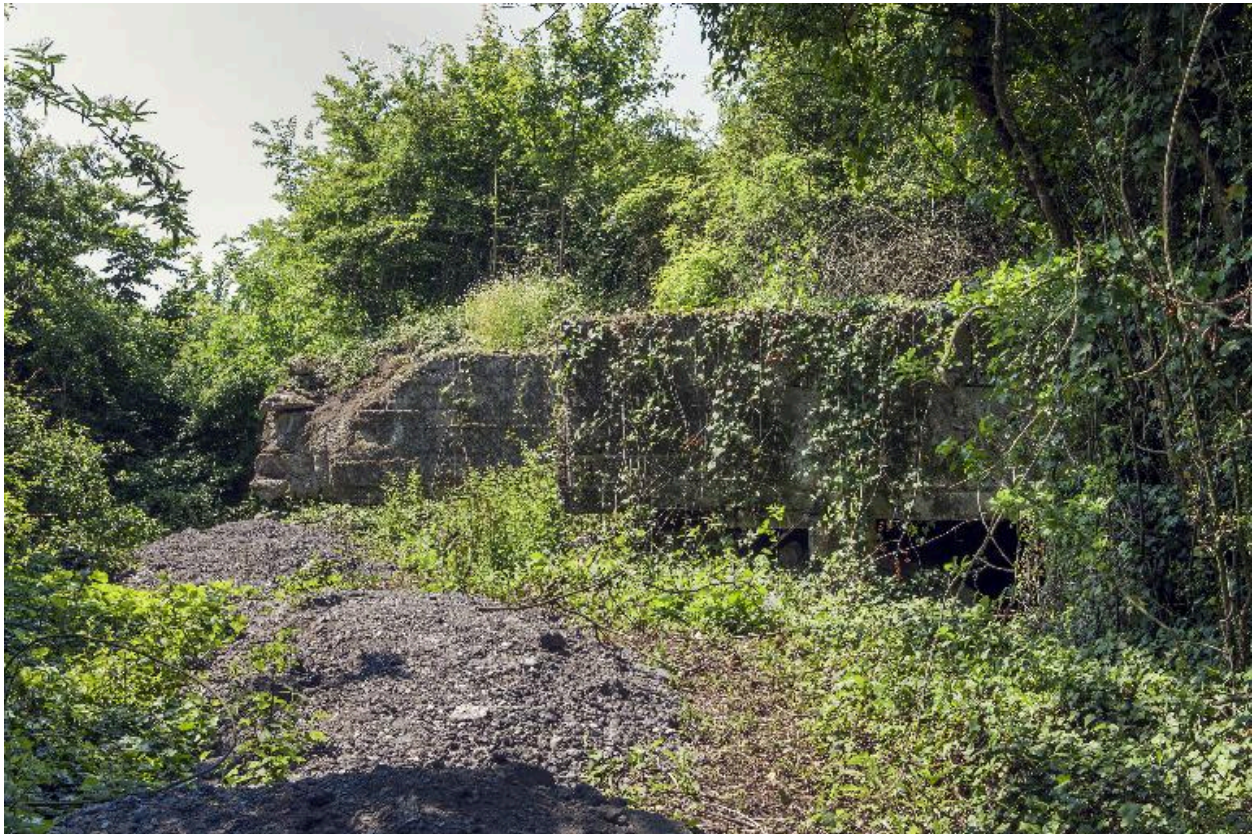
Vue générale, vers le nord-ouest
