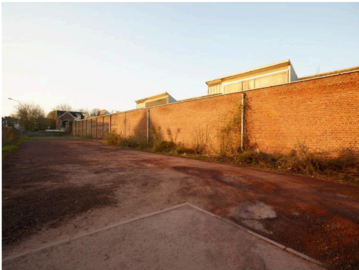
Élévation sur rue du magasin aux fils. Vue prise vers le sud.
