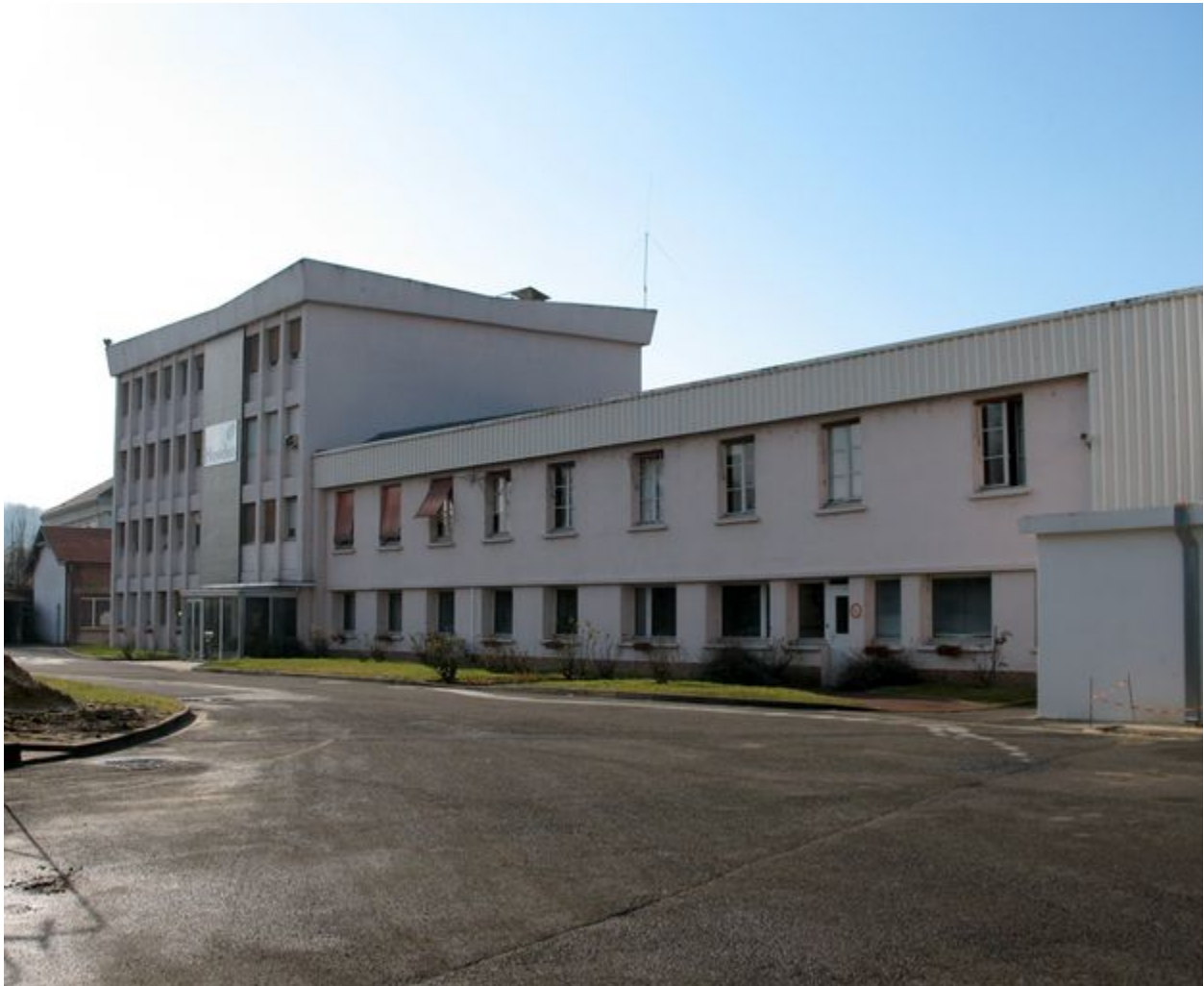
Le bâtiment des bureaux (2009).
