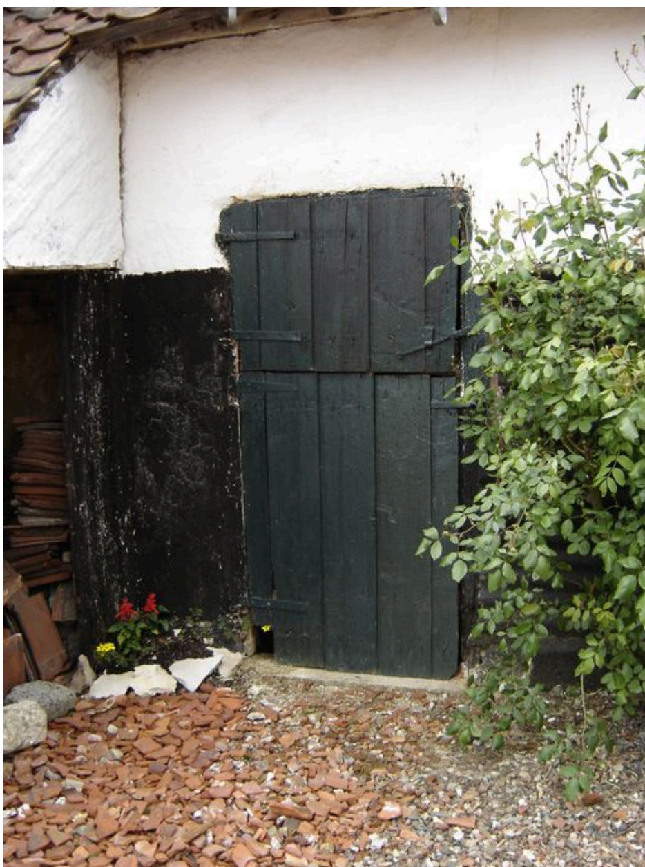
Vue détaillée d'une autre porte.
