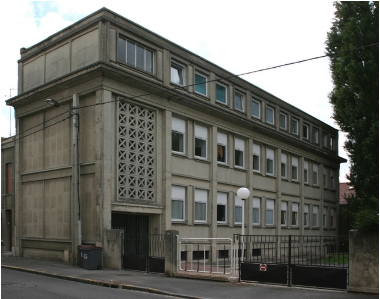
Façade antérieure des services sociaux.
