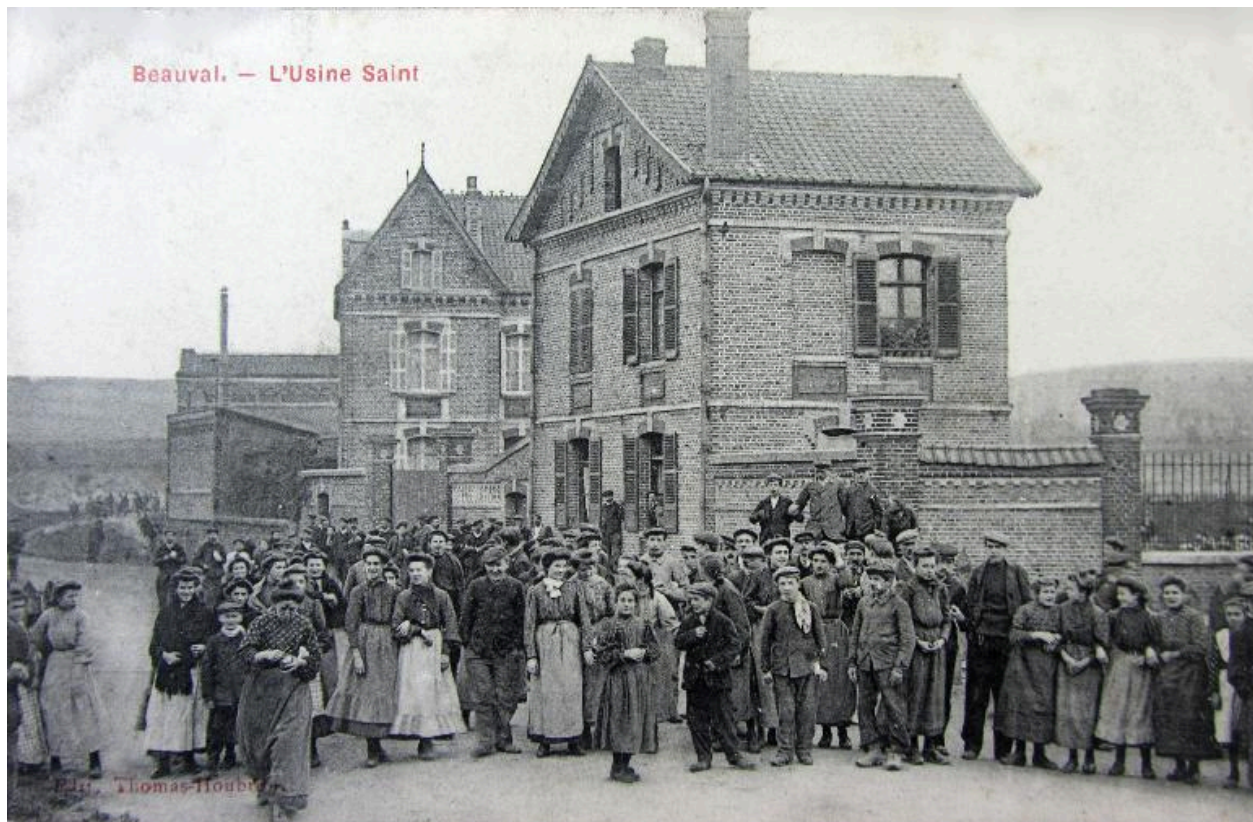
Personnel devant l'entrée de l'usine Saint, vers 1910 (coll. part.)
