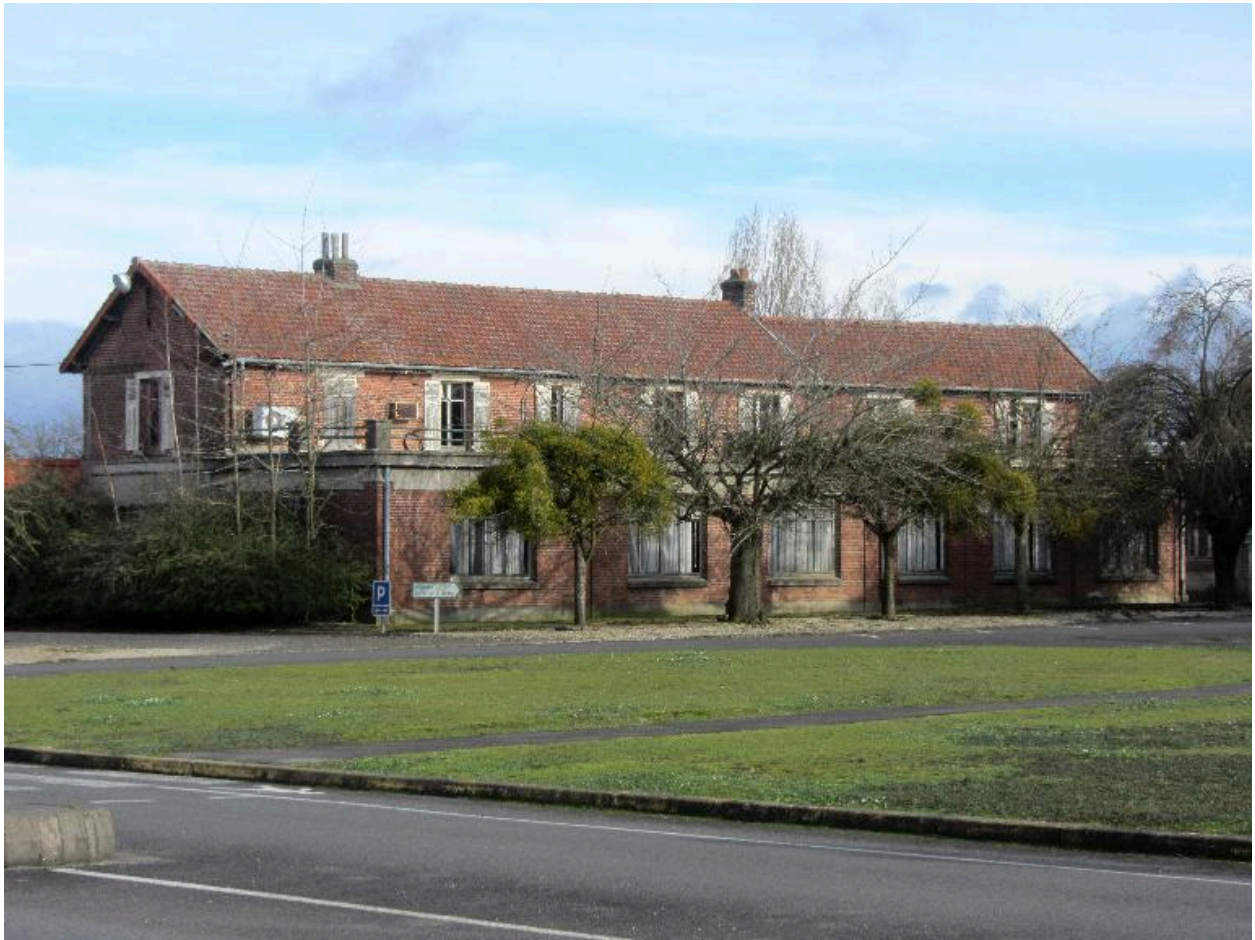
Façade postérieure des logements directement attenant à l'usine.
