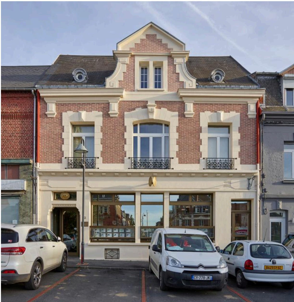
Ancienne banque Adam, n°3 place Faidherbe. Façade principale depuis la place. Construite en 1929 par l'architecte parisien Bonnard. (AD Pas-de-Calais, 10R9/115, dossier n°1955).
