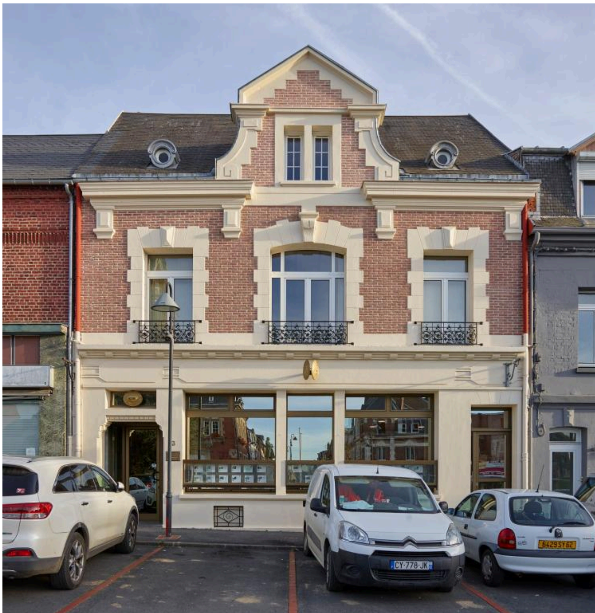
Ancienne banque Adam, n°3 place Faidherbe. Façade principale depuis la place. Construite en 1929 par l'architecte parisien Bonnard. (AD Pas-de-Calais, 10R9/115, dossier n°1955).
