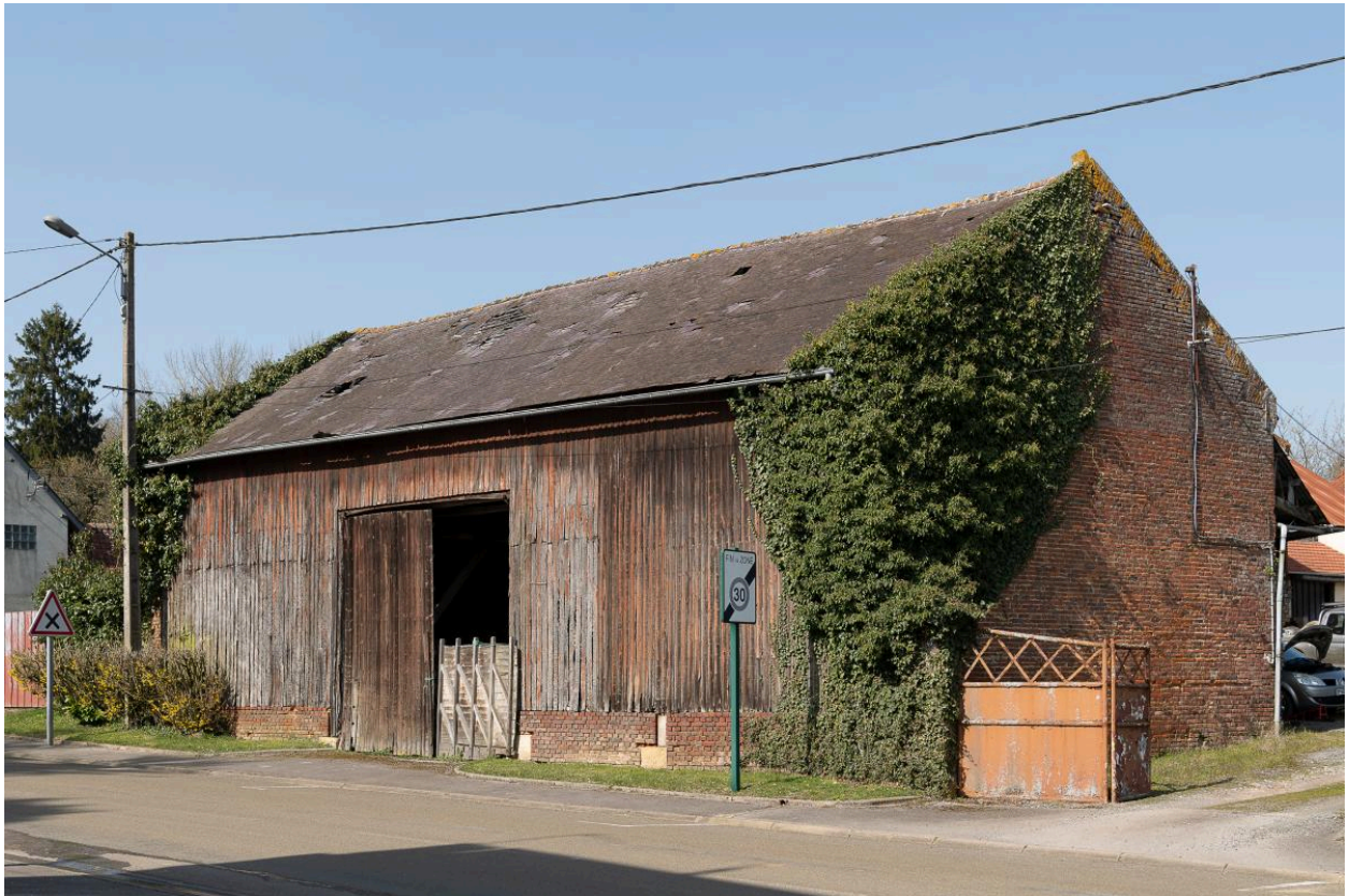
Ancienne grange sur rue, n°48 Rue Principale, vue depuis le sud.
