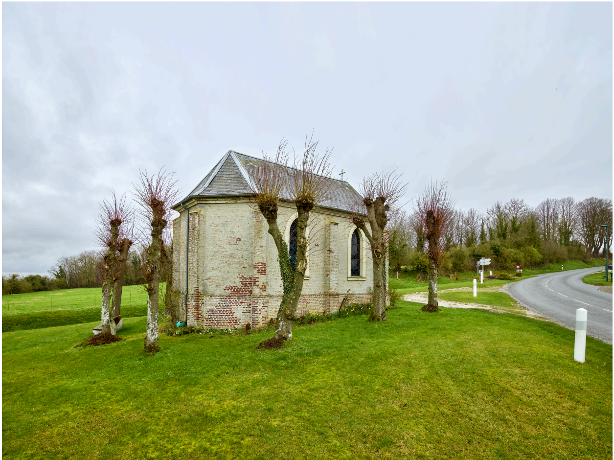
Vue de la chapelle, depuis le sud-ouest.
