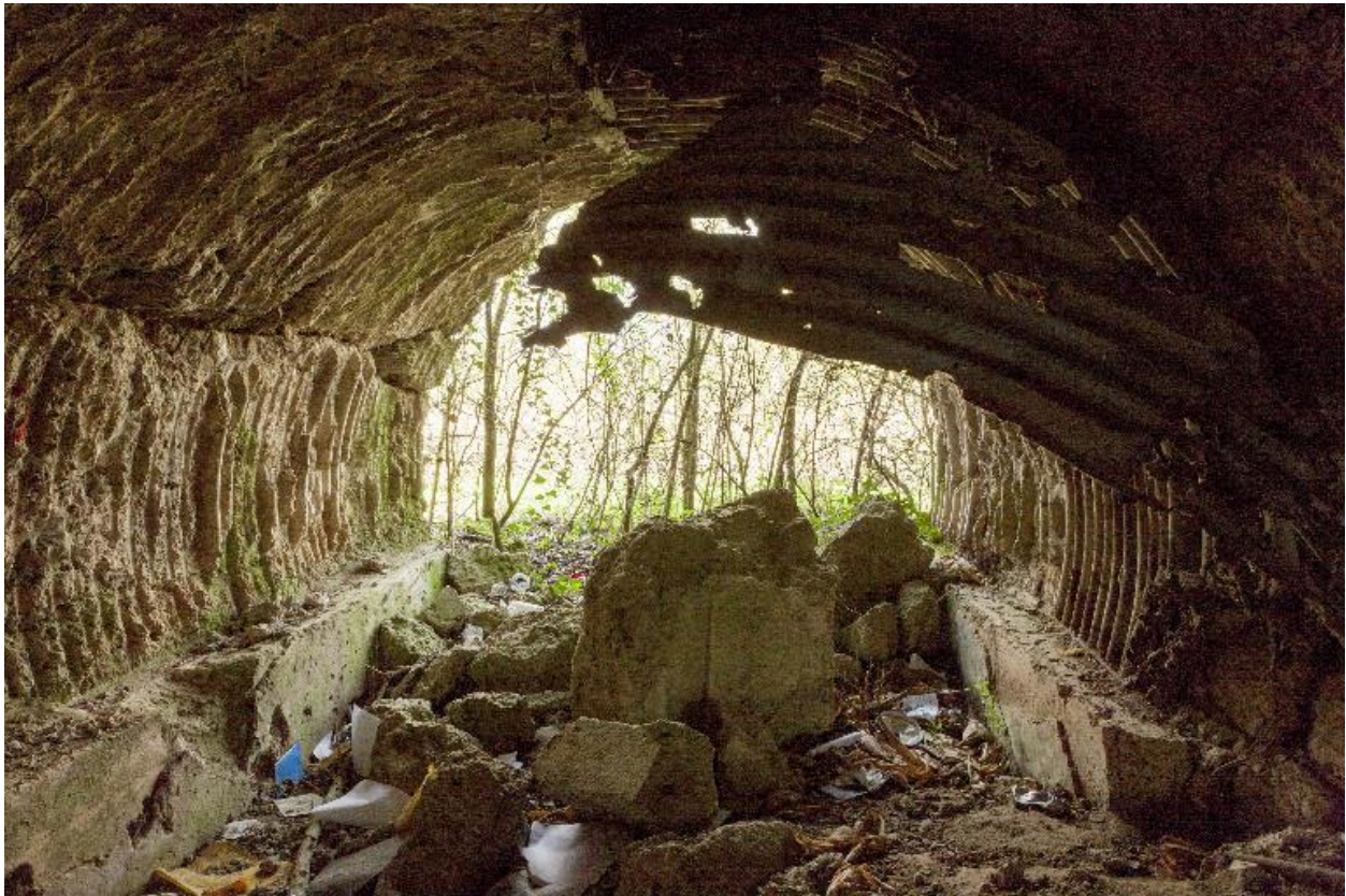
Edifice b. Vue intérieure vers le nord-ouest
