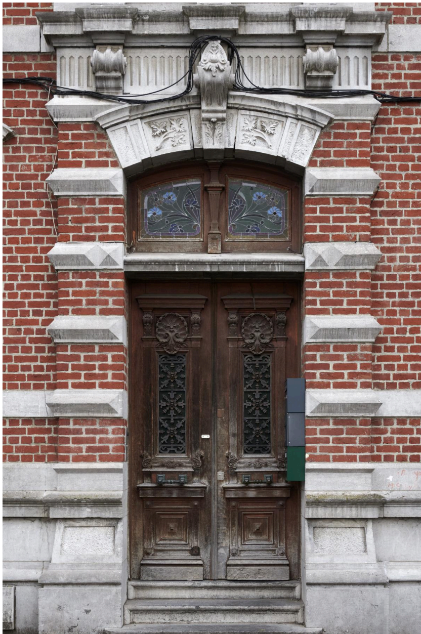
Détail : porte d'entrée, rue Descartes.
