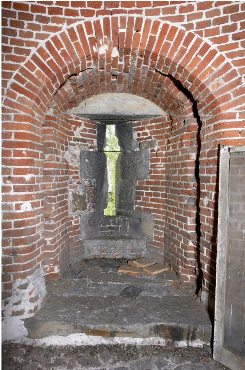
Niveau principal (R+1). Niche de tir nord-ouest.
