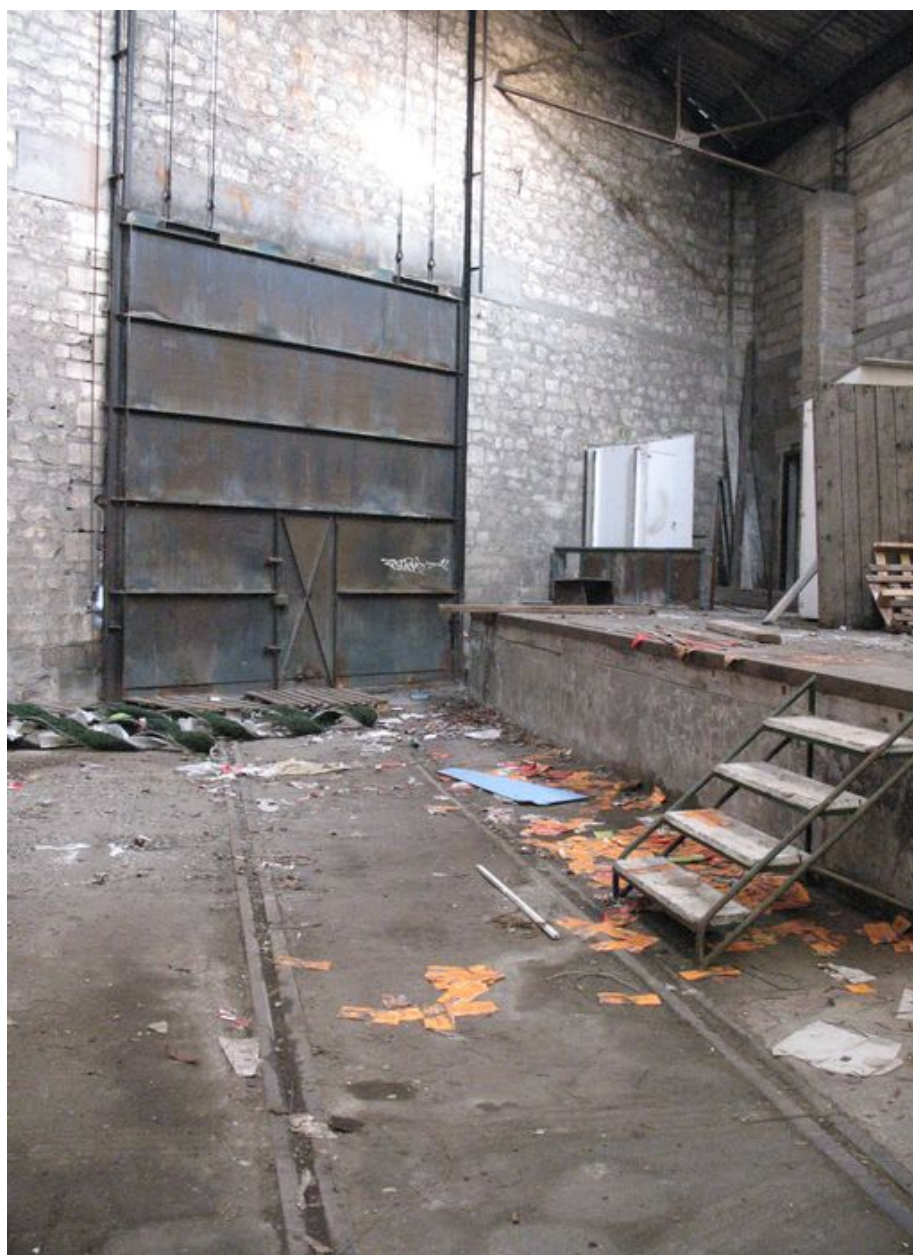
Raccordement ferroviaire des entrepôts.
