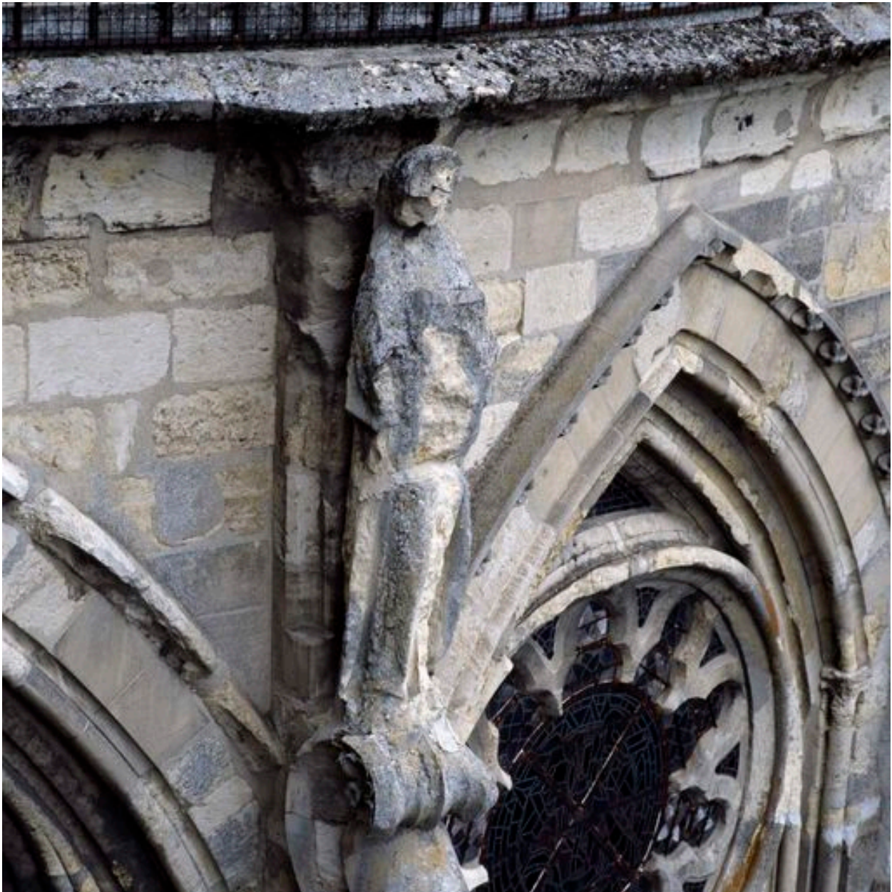
Vue d'un ange musicien de l'abside.
