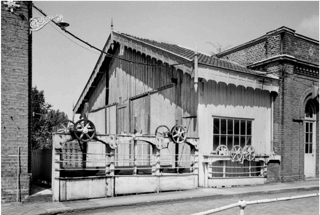
Cage du moulin, dit bâtiment d'eau, abritant la roue hydraulique Sagebien.
