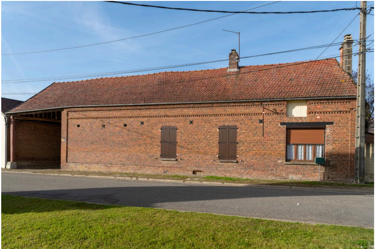
Logis en brique avec entrée charretière, n°59 rue Principale, vue depuis l'est.
