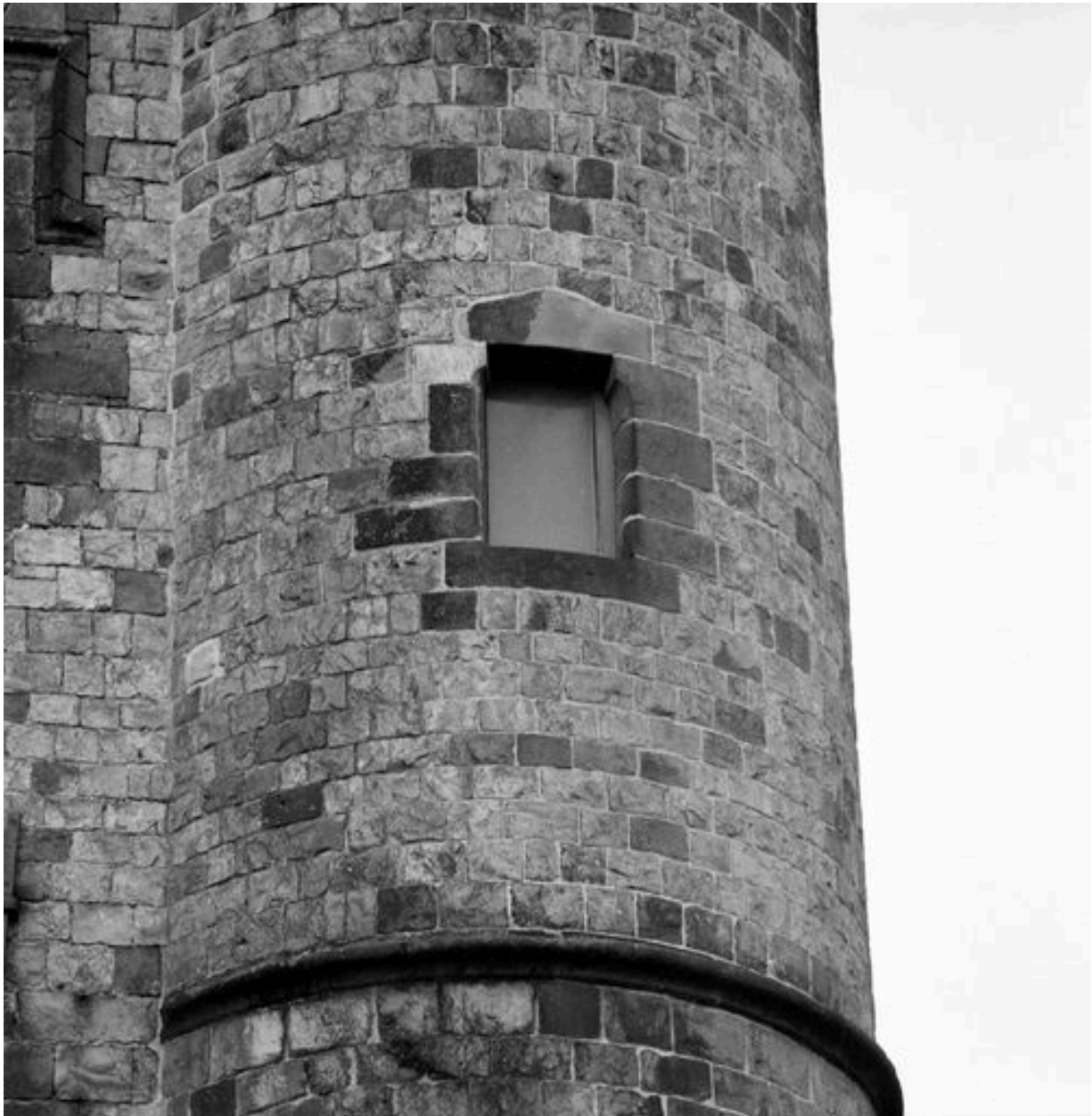
Corps de logis médiéval, façade, tourelle est, 2e étage : baie couverte par un linteau en bâtière reposant sur des coussinets.
