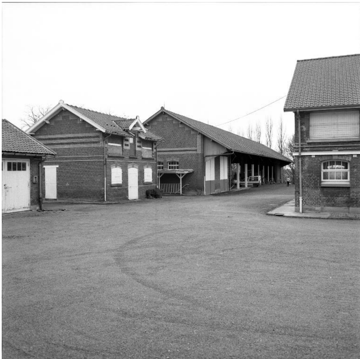
Ferme, hangar servant de remise et bâtiment de !, élévations antérieures, vue d'ensemble prise de trois quarts gauche.
