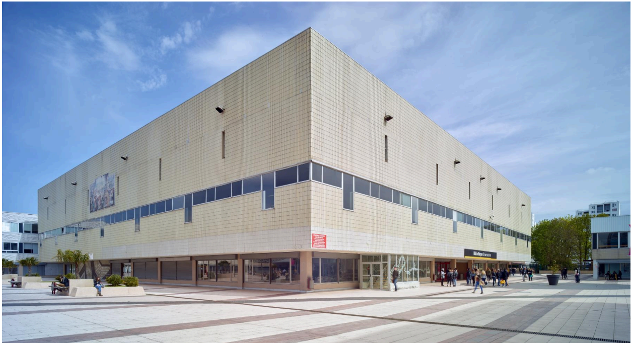
Vue d'ensemble depuis l'angle nord-ouest de l'édifice.
