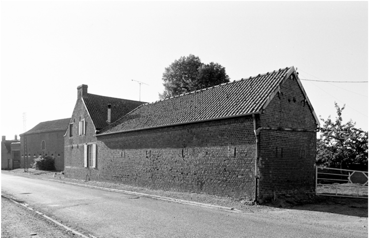
Vue extérieure de l'étable et du logis, depuis l'est.
