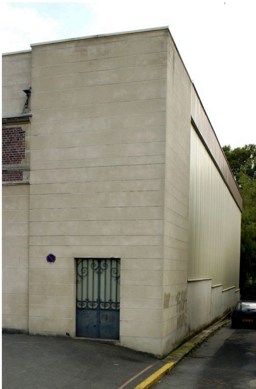
Façade transversale vers la rivière du magasin industriel.
