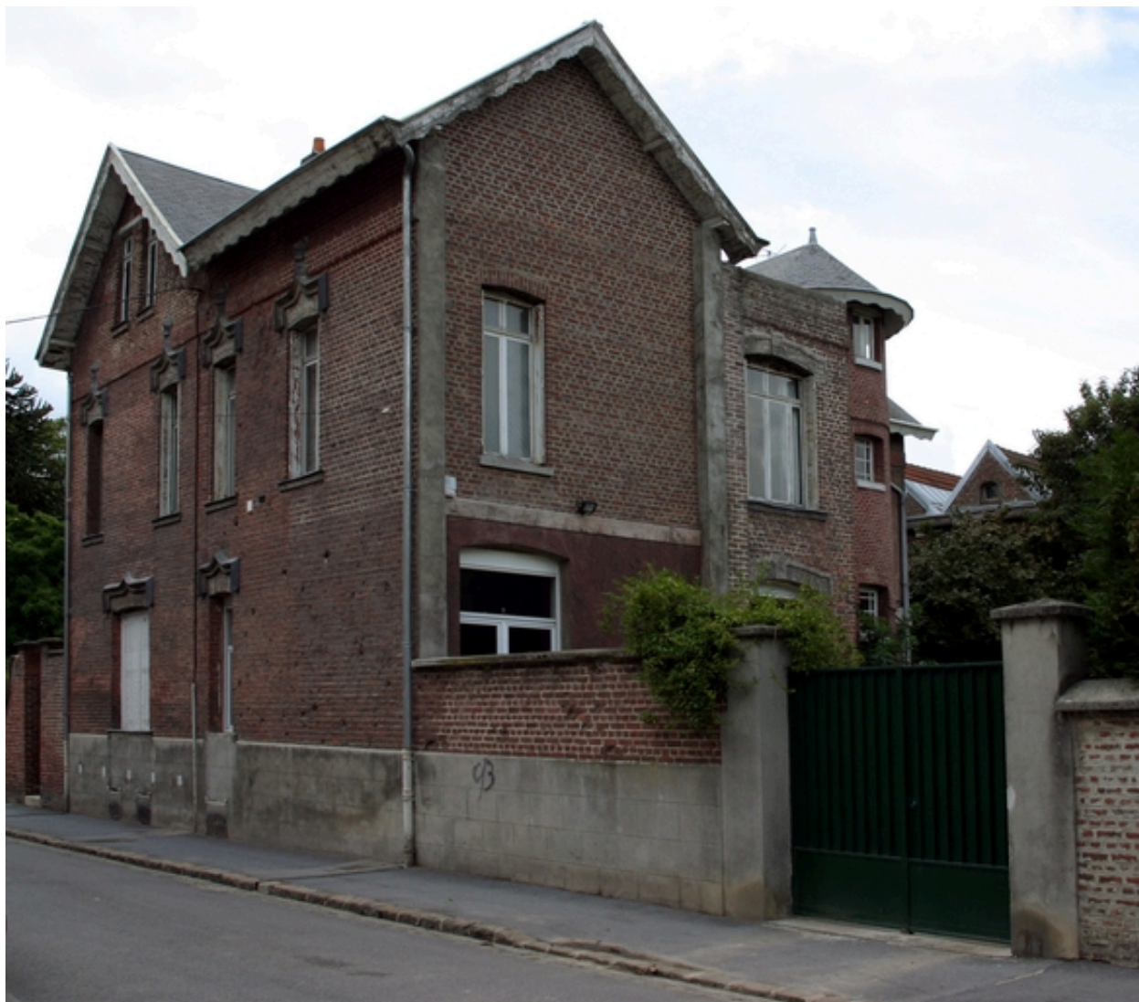
Façade postérieure du logement patronal.
