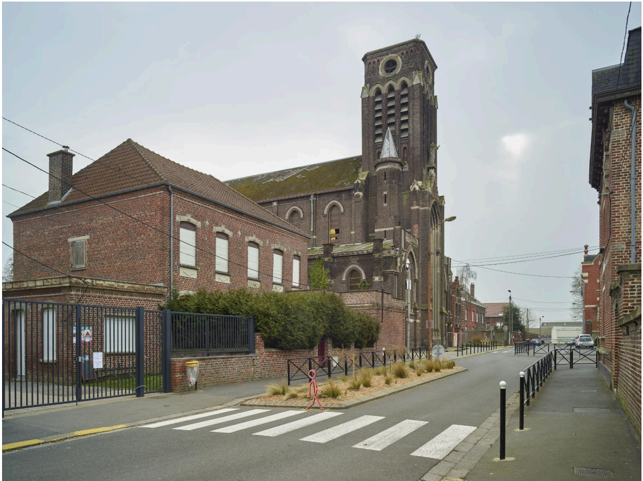
Vue générale de l'église vers l'est.
