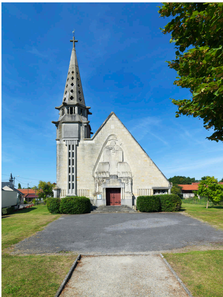
Vue générale de la façade.
