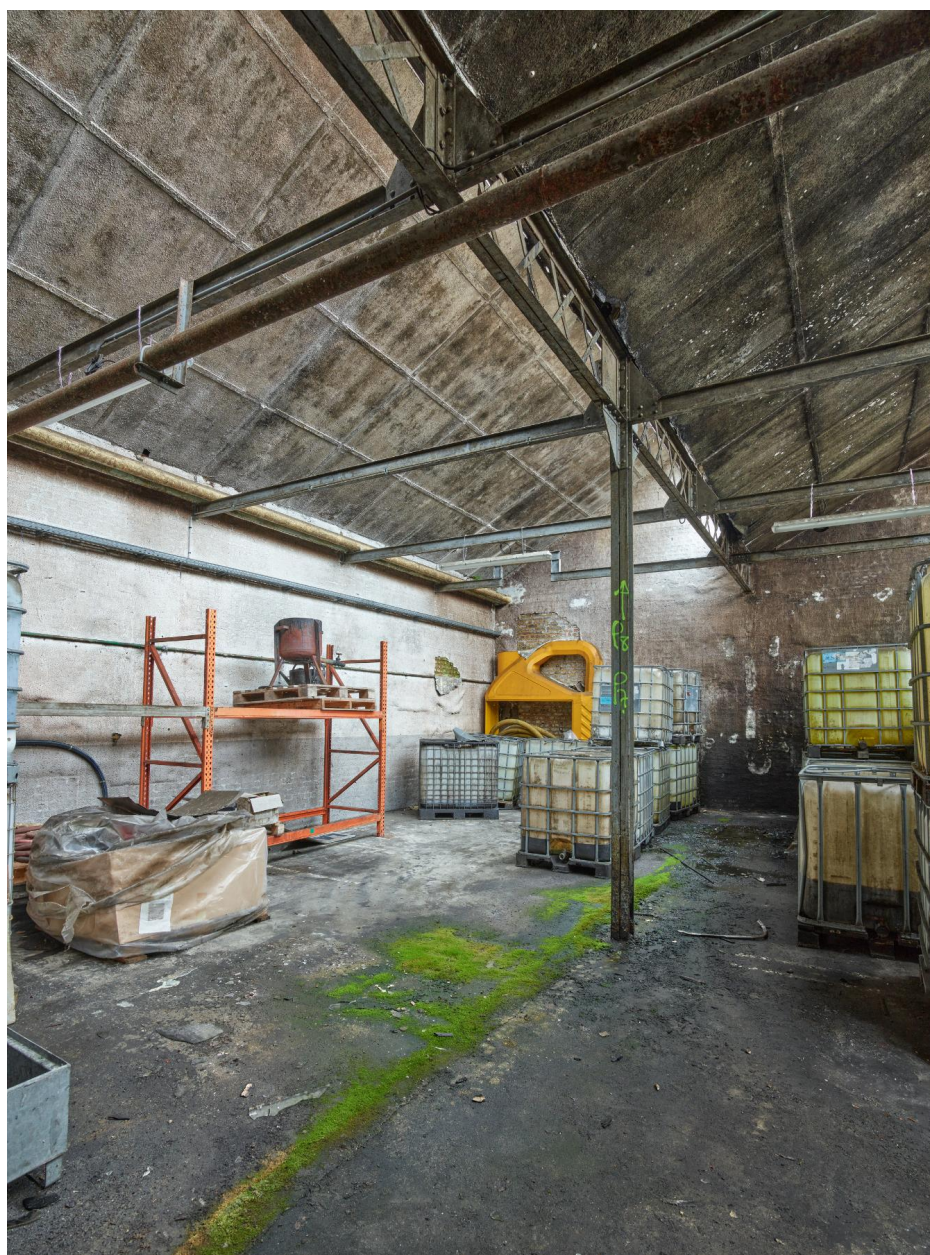
Intérieur de la partie avant, couverte en shed, d'un des ateliers (bâtiment M).
