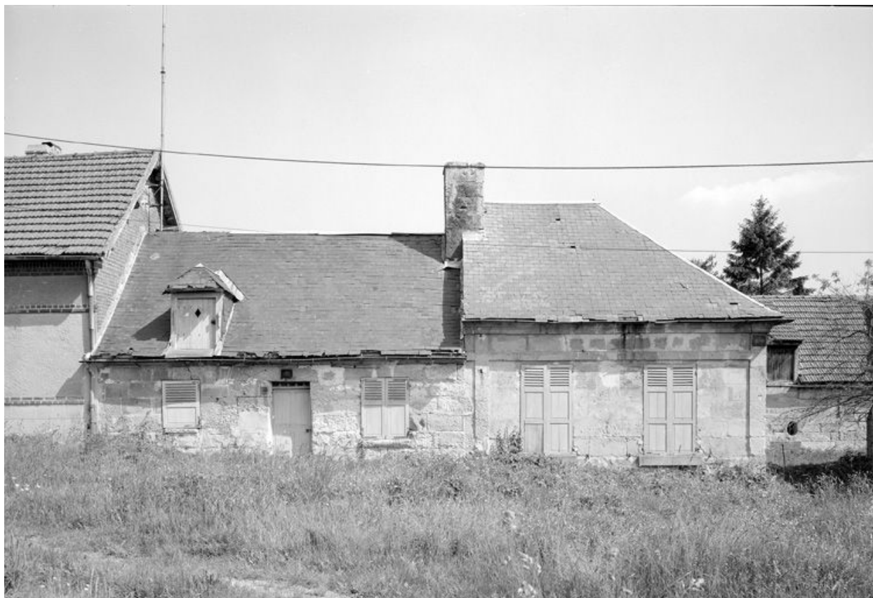
Logis. Elévation antérieure.
